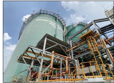
รูปที่ 2.2-25 ถังน้ำสำรองเพื่อการดับเพลิง
