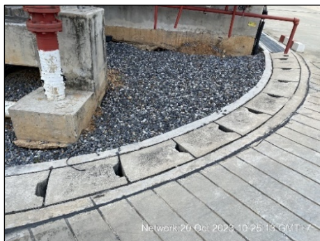
รูปที่ 2.2-5 รางรวบรวมน้ำฝนพื้นที่ทั่วไป
