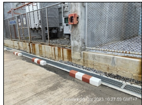
รูปที่ 2.2-6 รางรวบรวมน้ำฝนที่อาจปนเปื้อนน้ำมัน
