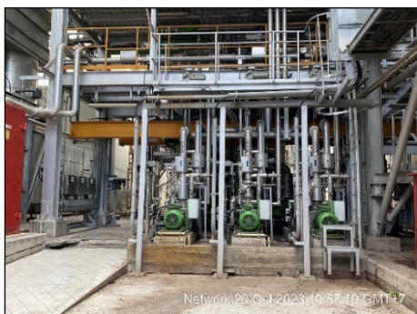
รูปที่ 2.2-30 ป้อนน้ำเติมหม้อไอน้ำสำรอง
