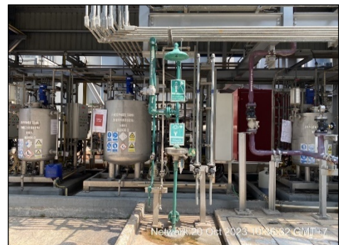
รูปที่ 2.2-27 อ่างล้างตา/ฝักบัวฉุกเฉิน
