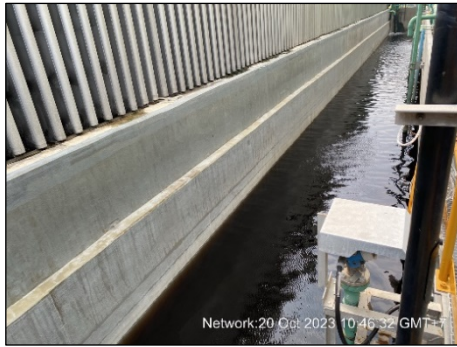
รูปที่ 2.2-9 บ่อพักน้ำทิ้ง ขนาด 3,700 ลูกบาศก์เมตร
