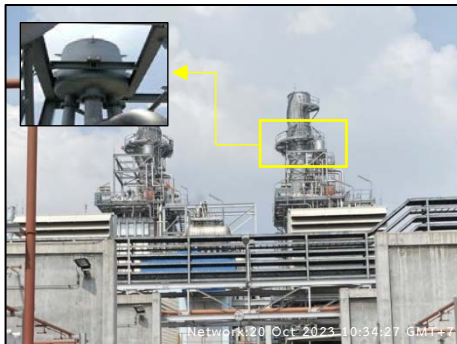
รูปที่ 2.2-13 อุปกรณ์ลดเสียง (silencer)
